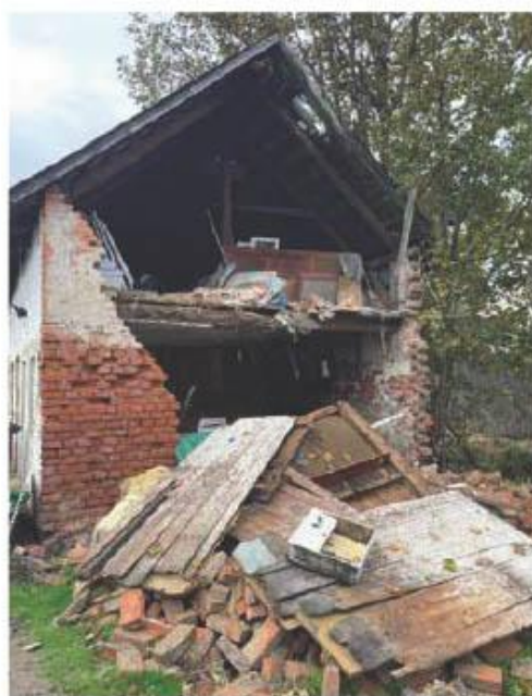
Fot. 12. Uszkodzenia budynków spowodowane powodzią w 2024 roku - archiwum PIIB
