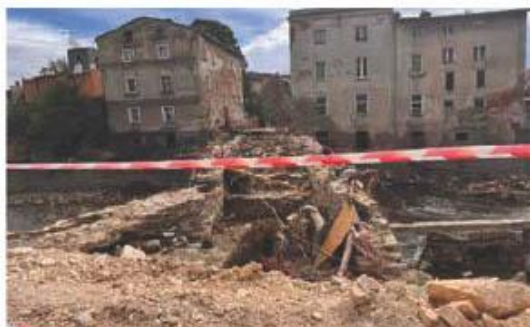
Fot. 17. Uszkodzenia budynków spowodowane powodzią w 2024 roku - archiwum PIIB
