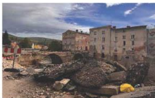
Fot. 15. Uszkodzenia budynków w Łądku Zdroju spowodowane powodzią w 2024 roku - archiwum PIIB
