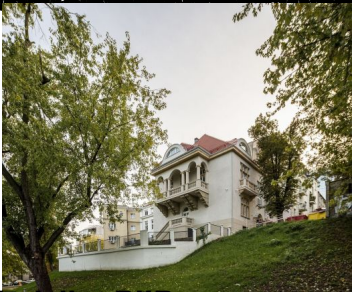
Siedziba PIR przy ul. Krzywokiej 1 w Warszawie. Budynki w trakcie modernizacji
