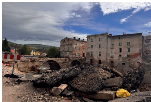
Fot. 12. Uszkodzenia budynków w Łądku-Zdroju spowodowane powodzią w 2024 roku – archiwum PIIB
