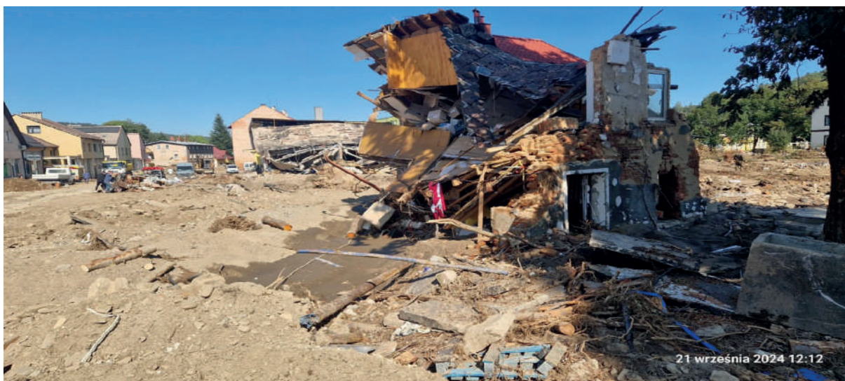
Fot. 5. Zniszczenia spowodowane powodzią we wrześniu 2024 roku – archiwum PIIB
